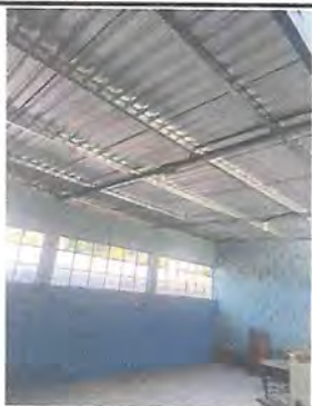
Foto1: evidencia de muro reforzado, techo y sistema eléctrico en aula.
