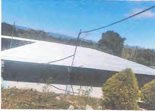
Foto1: Evidencia del trabajo de sustitución de techo finalizado parte exterior.
