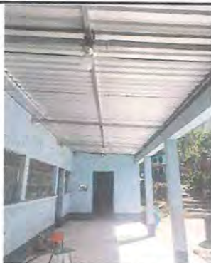
Foto 3: Evidencia de sustitución de techo y sistema eléctrico en corredor.
