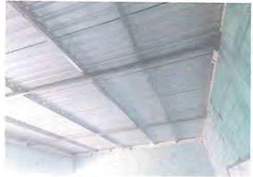
Foto 2: Evidencia de trabajo de sustitución de techo finalizada parte interior de un aula.
