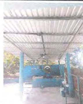
Foto 2: Evidencia de sustitución de techo y sistema eléctrico en corredor.
