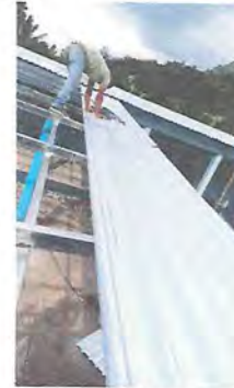
Foto 2: Durante enlaminado en corredor.
