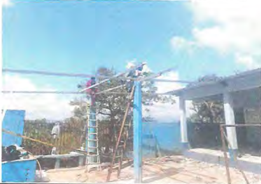
Foto 1: Durante colocación de costaneras en corredor.
