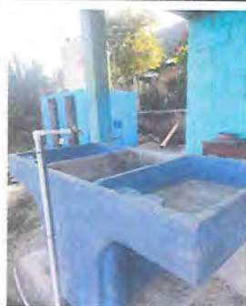
Foto 5: Instalación de pila para el área de cocina.
