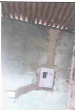
Foto 5: Sustitución de cableado eléctrico.
