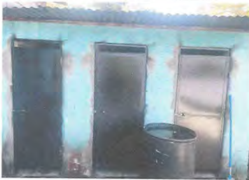
Foto 3: Puertas nuevas colocadas en sanitarios.
